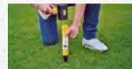
3. Schraube mit einem Hammer bis Stop-Markierung (ca. 4 cm) unter die Erdoberfläche einschlagen.
