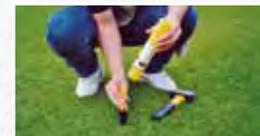
2. Fasern zusammen-drücken und die Eintreibhilfe auf der Schraube befestigen.
